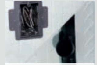
Installer l'électricité, la plomberie et la toiture
