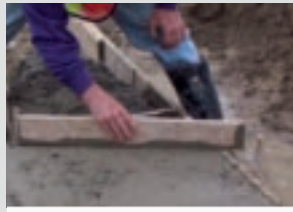
Réaliser la fondation pour recevoir les blocs
