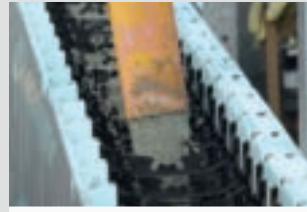
Couler le béton dans les murs
