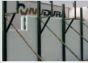
Aligner les murs pour le coulage du béton
