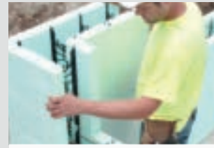
Empiler les blocs et créer les ouvertures
