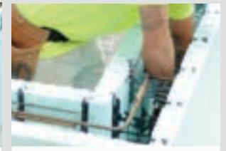
Placer les barres d'armature dans les murs
