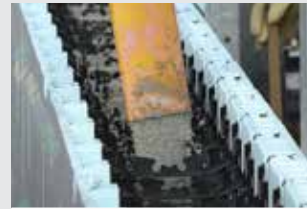
Coloque o betão nas paredes
