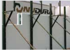
Alinhe as paredes para a betonagem
