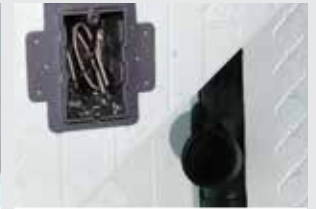
Instale o telhado, as canalizações e a eletricidade
