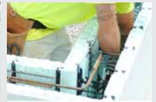
Coloque os varões para betão nas paredes
